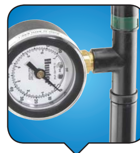
МОНТАЖ НА ИЗМЕРВАТЕЛ МР
