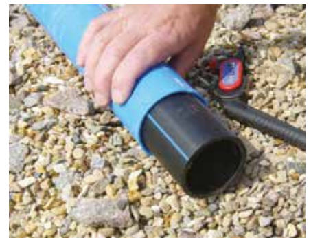
Ивътрешният слой е готов за изглаждане и запояване.
