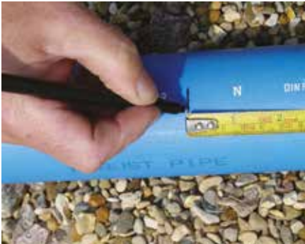
Измерете и маркирайте тръбата.
