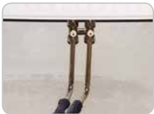
Монтаж със свързващи коляна
