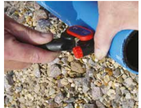
С леки помпещи движения придвижете инструмента до маркировката.
