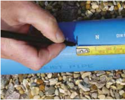
Измерете и маркирайте тръбата.
